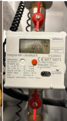
Wärmemengen- zähler
